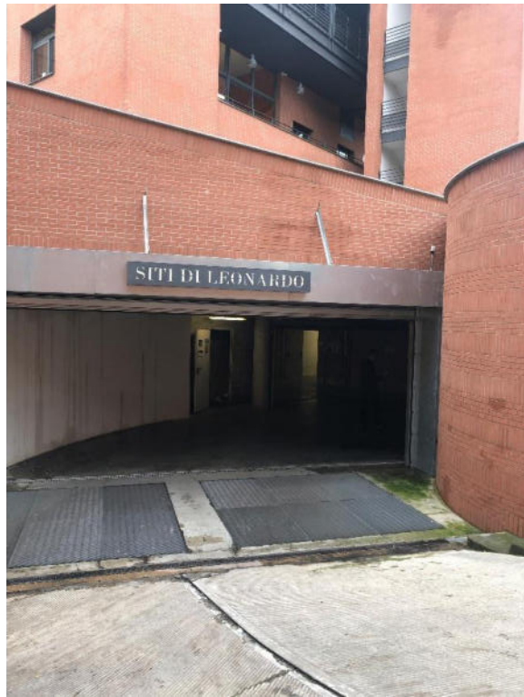
Viste rampa box
