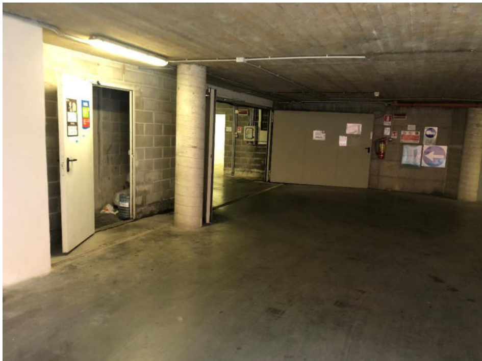
Vista corsello box
